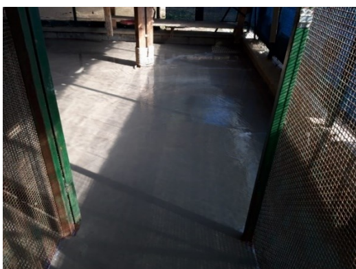
Pavimentazione recinti gatti;
